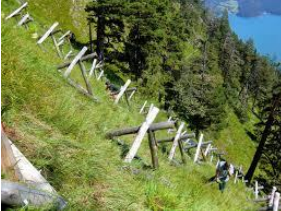
სურათი 42: თოვლის ზვავისგან დამცავი საყრდენები
